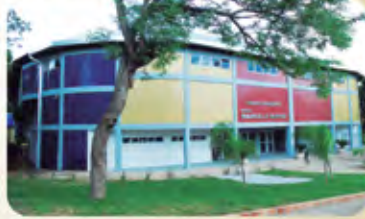
Reconstrução completa do Ginásio de Esportes Marcelo Mioso
