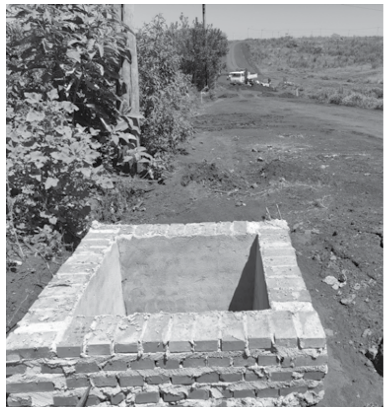
Obra de drenagem pluvial na Rua Antônio Pereira
