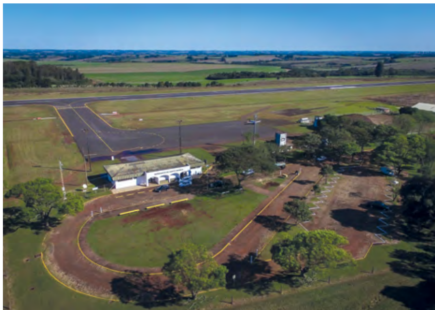
Vista aérea do Aeroporto Regional Sepé Tiaraju
