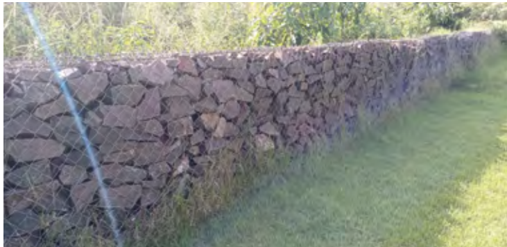
São muros constituídos com gaiolas metálicas formadas por fios de aço galvanizado preenchidas por pedras.
