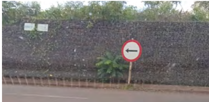
São muros constituídos com gaiolas metálicas formadas por fios de aço galvanizado preenchidas por pedras.
