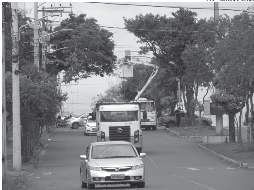
Instalação de semáforo na Av. Salgado Filho, zona norte de Santo Ângelo
