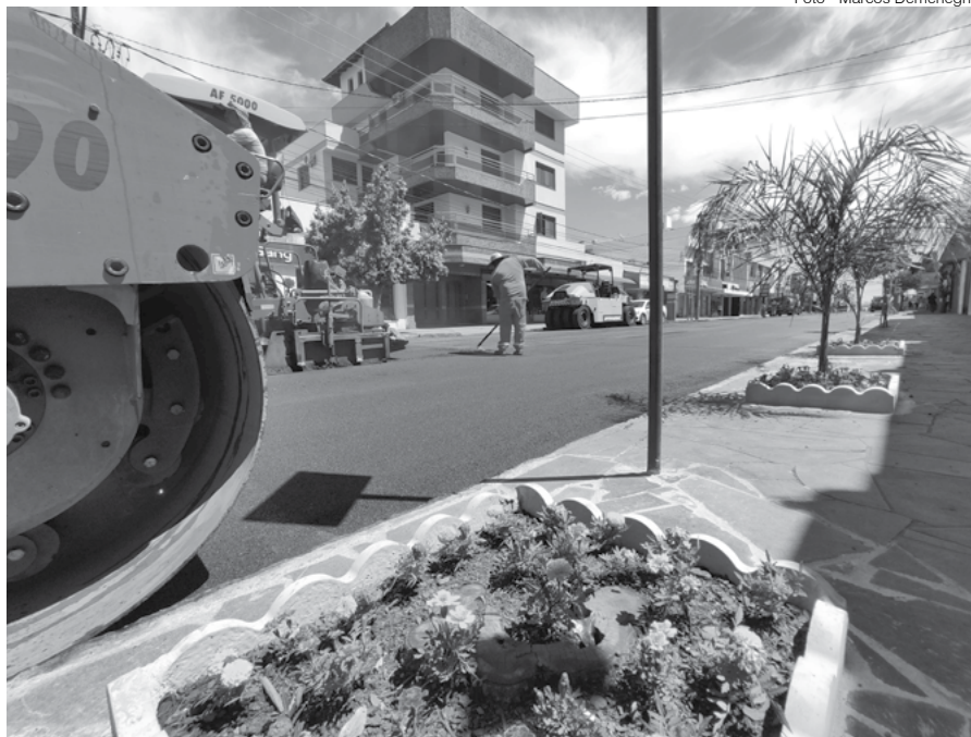
Trecho da Av. 25 de Julho que já recebeu asfalto na tarde de segunda-feira
