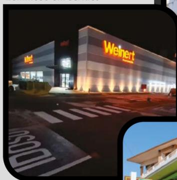
Revestimento em ACM e Luminoso em acrílico
