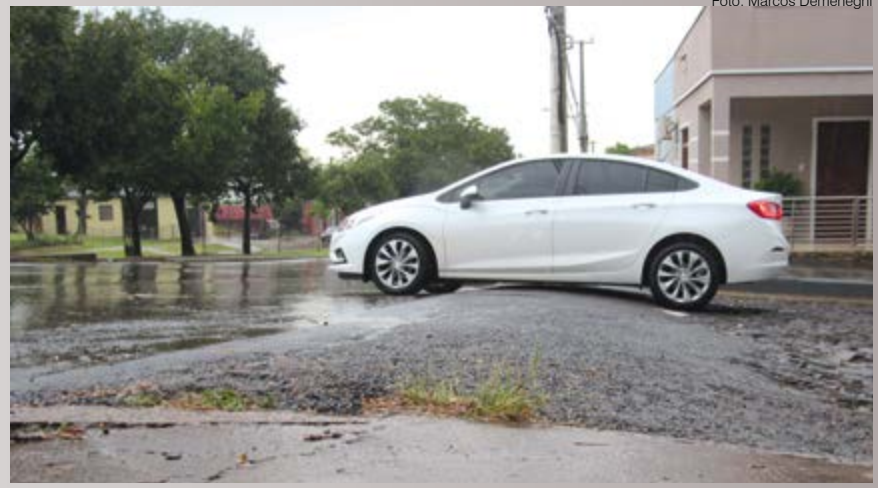
Cruzamento da Rua Marques do Herval com a Av. Salgado Filho
