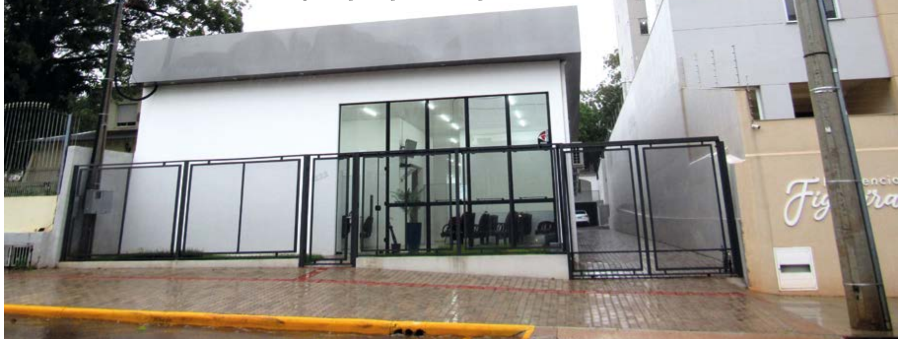
Edificação onde está localizada a nova sede da Defensoria Pública Regional em Santo Ângelo - Av. Venâncio Aires, 1222
