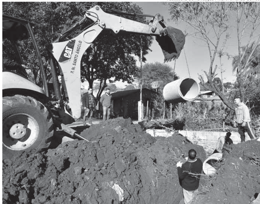
Obras de drenagem pluvial no Bairro Emília-foto fernando gomes
