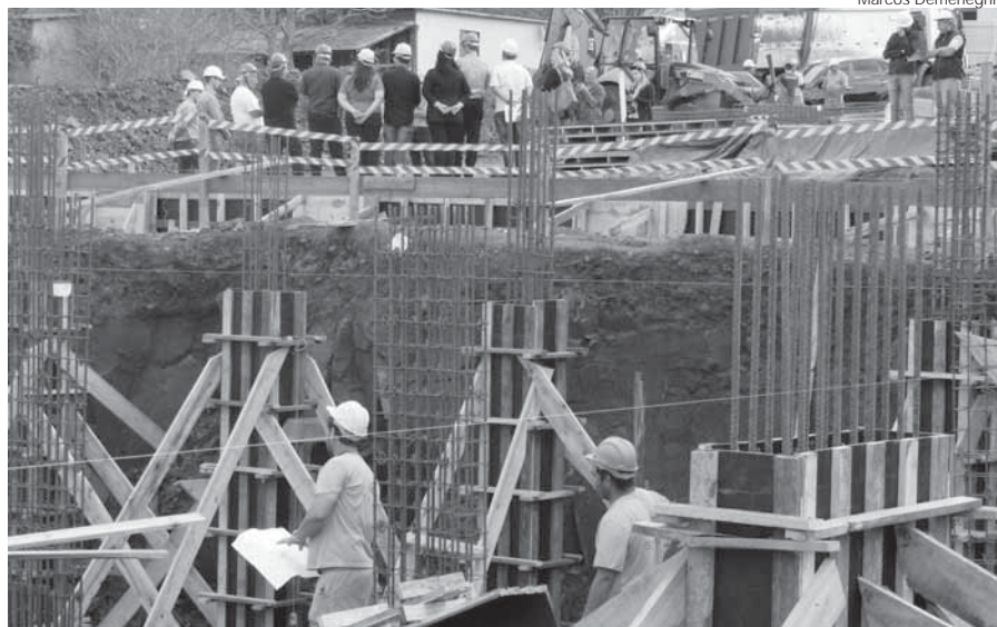
As fundações já estão sendo concluídas
