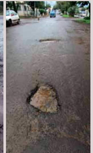
Avenida São João
