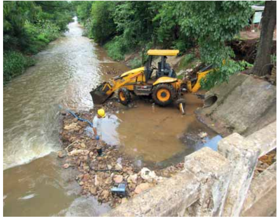
Retroescavadeira abre caminho para a ligação de uma rede coletora com o interceptor
