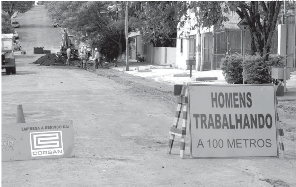
Obras de esgotamento sanitário realizados no Bairro Centro Sul
