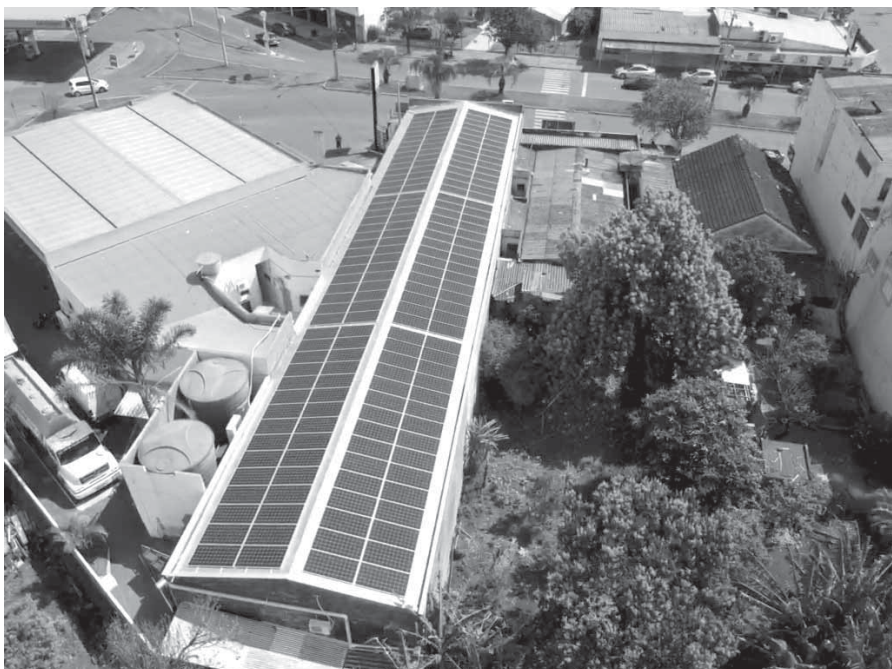
Nesta ilustração destacamos o maior sistema de captação solar em operação em Santo Ângelo. Projetado e instalado no Supermercado Cripny de Dari Zanusso por uma empresa local, o sistema possui 180 módulos fotovoltaicos e capacidade de geração de 7.000 kwh por mês
