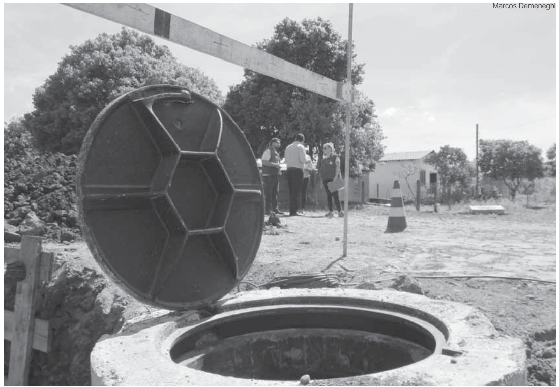
Obras de implantação de redes de esgoto sanitário nos bairros Emília e Menges
