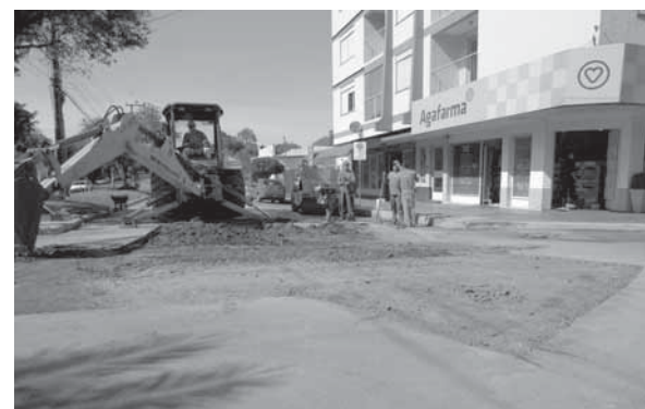
Recuperação do asfalto na Avenida Getúlio Vargas
