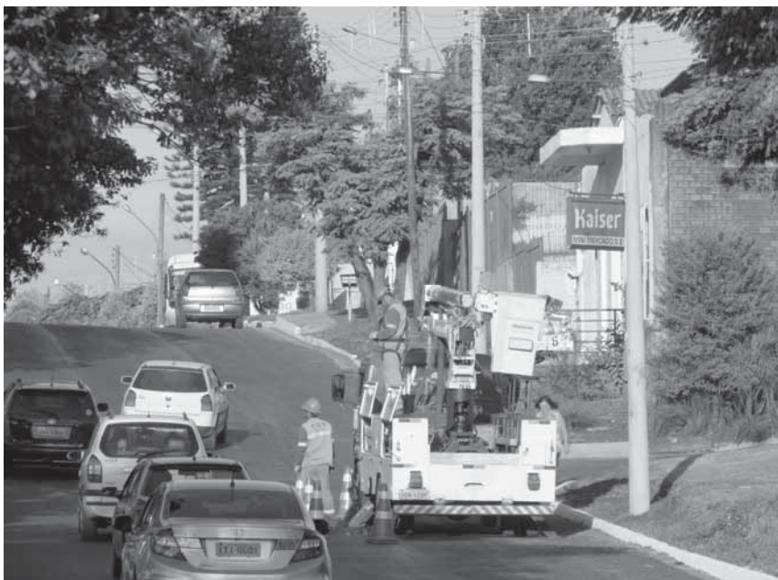
Troca de postes de madeira por outros de concreto deixam os moradores sem luz
