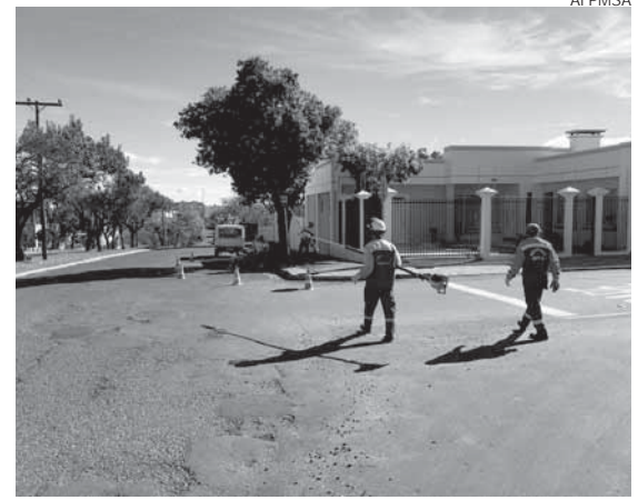
Serviços de melhorias estão sendo executados no centro e nos bairros do município
