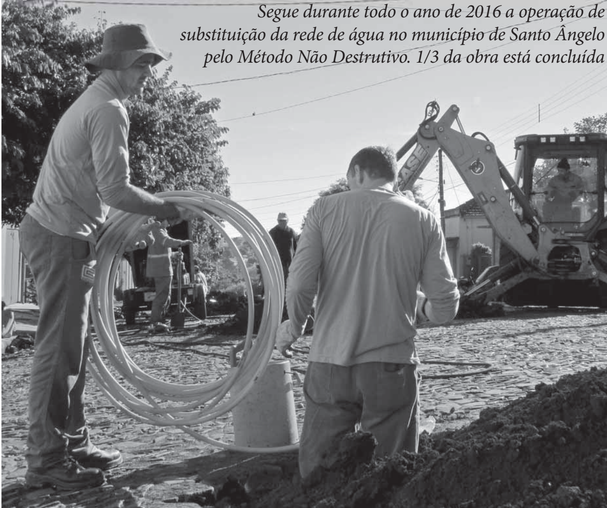
As residências são ligadas a rede nova com canos flexíveis e também são introduzidos pelo Método Não Destrutivo
