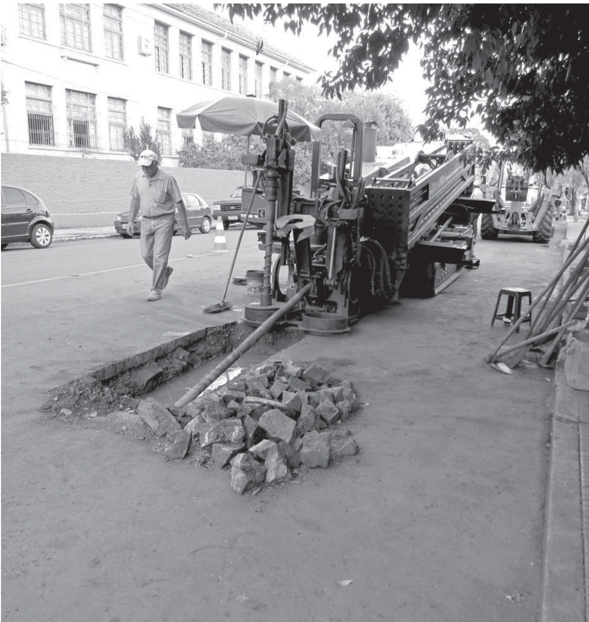
Perfuratriz que usa o método MND - Método não destrutivo realiza serviço na Rua Antunes Ribas no mês de Abril
