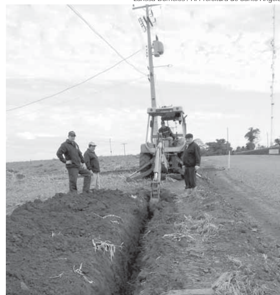
Serviço garantirá adequação para receber a cobertura asfáltica da estrada
