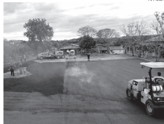
Entre as obras estão serviços de pavimentação do acesso e do estacionamento do CTG Tio Bília
