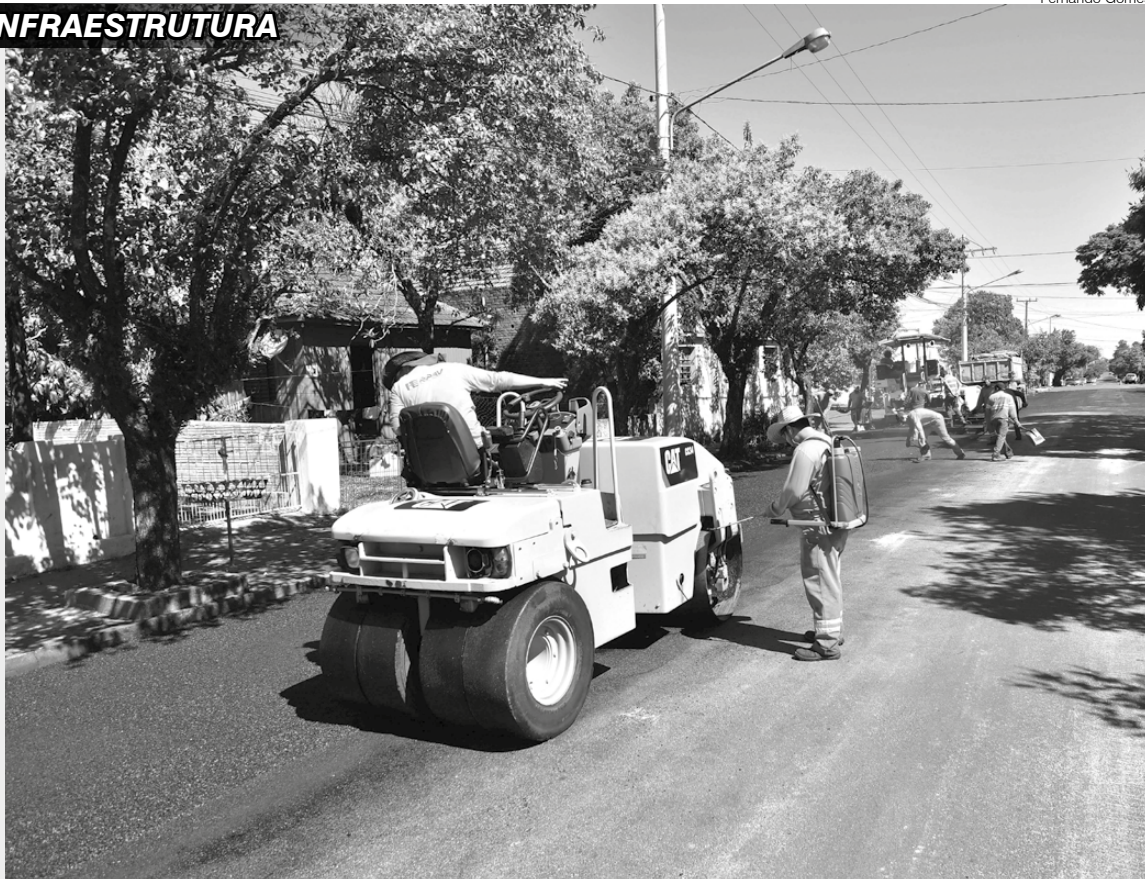
Trabalho de asfaltamento da Rua Marechal Floriano
