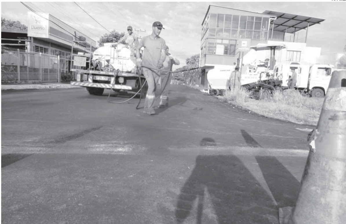
Trabalhadores da empresa contratada já executam a cobertura asfáltica da Rua Décio Martins da Costa, no Bairro Ditz. Durante a semana realizaram a limpeza, retirada de vegetação, terra e outros materiais soltos próximos ao meio fio
